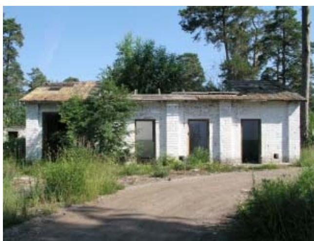
Foto 3. Lagunenud laohoone Kaberneemes
